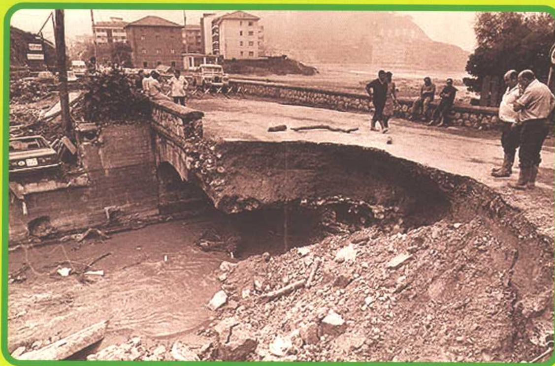
26 de agosto de 1983. Inundaciones del País Vasco y Cantabria. Casas, carreteras, calles, vehículos... las inundaciones arrasaron con todo; incluso con este puente de Bakio. (Foto. elcorreodigital. http://canales.elcorreodigital.com/especiales/inundaciones/portada.html .)
