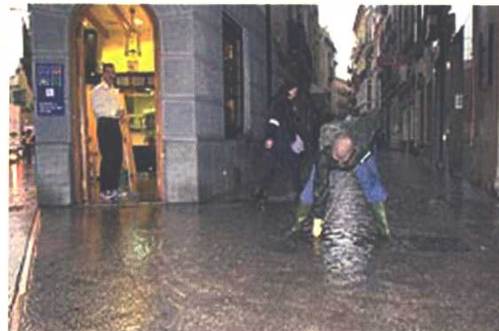
Bomberos limpiando alcantarillado (Foto. Sofía González)
